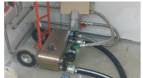
Plattenwärmetauscher zur Systemtrennung
