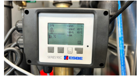
Mischer kann auf jeden beliebigen Wert ab 20 °C für den Vorlauf eingestellt werden
