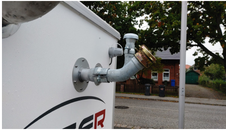
Einfache Befüllung von außen
